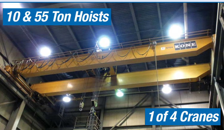
KONE 65 TON X 45' DOUBLE GIRDER CRANE
